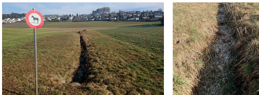
Abb. 9 Oberer Abschnitt des Zuflusses Chommlibach (links), trockenes Bachbett (rechts)
