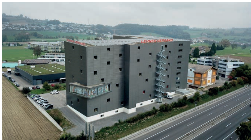
Abb. 6 Aufstockung Lagerhaus Lehner Versand AG auf 30 m Gesamthöhe, Visualisierung (rast architektur, August 2019)
