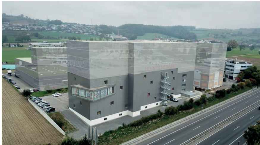
Abb. 5 Visualisierung der Aufstockung im Gebiet Zellgut mit Transparentgeschossen, Westansicht (Rast Architektur, Januar 2020)
