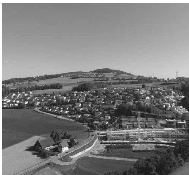
Während der Bauphase der ersten Etappe des Kirschgartens
