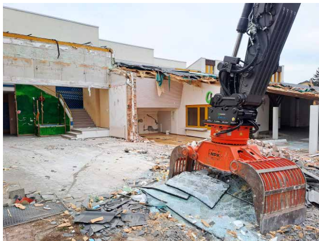
Abbruch des bisherigen Primarschulhauses
