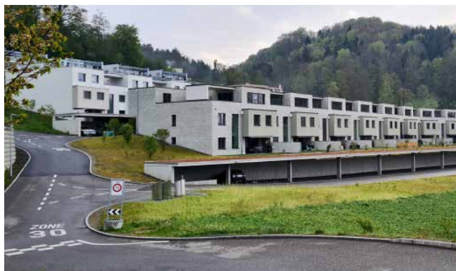
Ansicht zweite Etappe vorne und erste Etappe hinten
