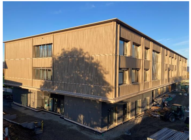
Neubau Schulhaus Grundhof
