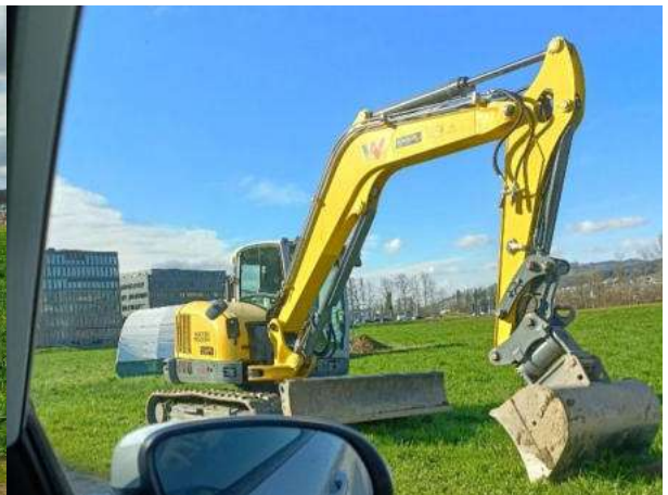
Bagger Wacker Neuson ET90 (8 to Raupenbagger) eingesetzt für Baggerschlitz, vom 01.04.2025
