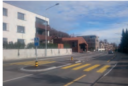
Abb. 29 Dorfstrasse beim Restaurant OX'n
